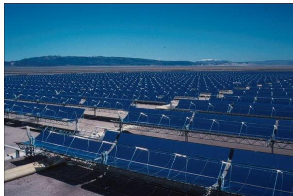
**Champ de capteurs cylindro-paraboliques** des centrales thermiques solaires à Kramer Junction (SEGS), Californie.
